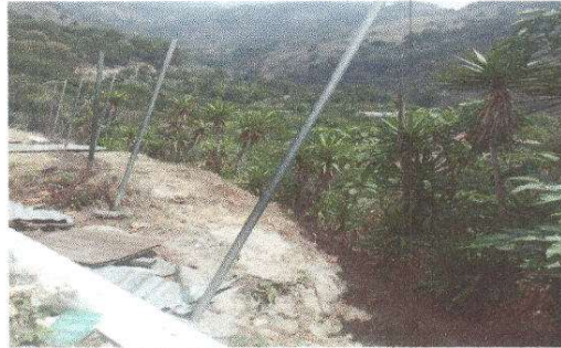
Foto 8: Reparación de tubo hg y malla galvanizada.
