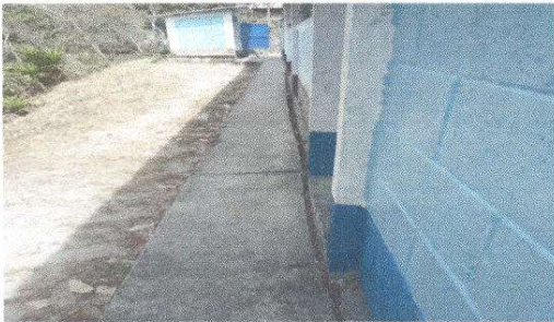
Foto 7: Reparación de banqueta de concreto.
