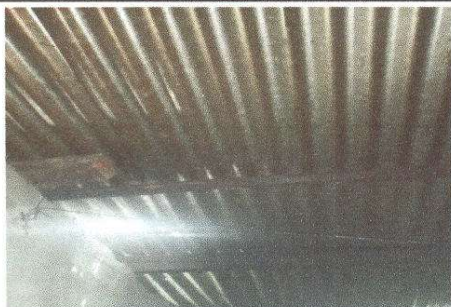
Foto 1: Sustitución de lámina por lámina troquelada y sustitución de estructura de soporte de metal por metal.
