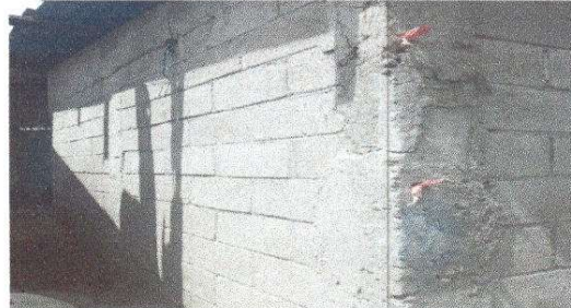
Foto 12: Repello de muro de cocina exterior e interior
