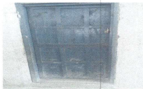
Foto 2: Sustitución de puerta.
