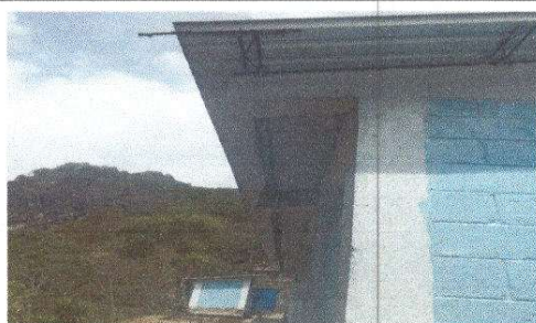
Foto 6: Canales y bajadas de agua
